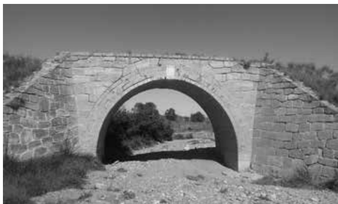
Obra nº1, Rambla de Enmedio, pk 4+250, entre Cariñena y Longares.
