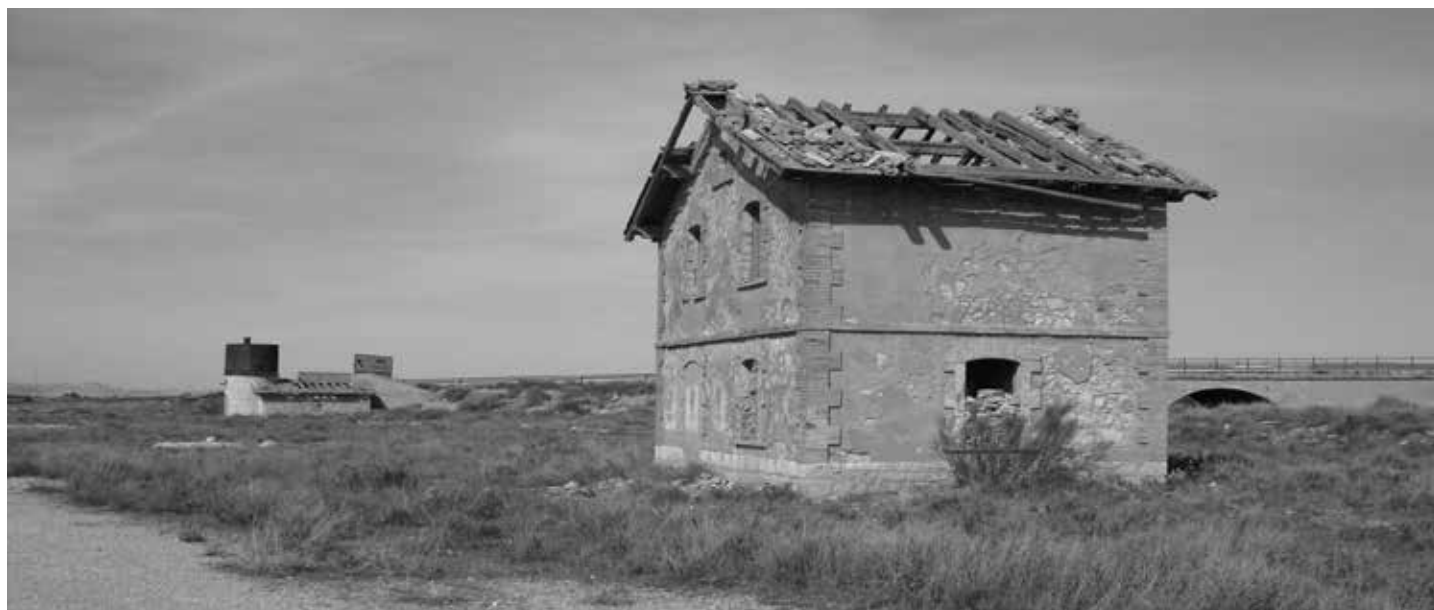
Edificios anexos a la estación de Muel.
