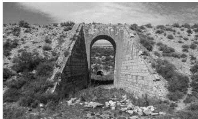
Obra nº 6, Alcantarilla Hoya Zambriil, pk 6+500, entre Cariñena y Longares.
